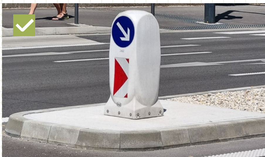
14 Příklad ukončenia ostrovčeka betónovou plochou pre osadenie dopravného značenia. Bratislava, Karadžičova ulica
